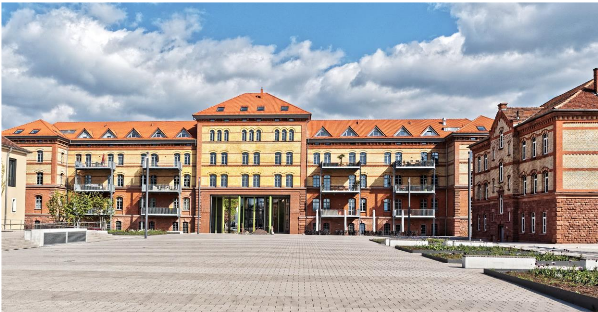
Haupteingang des Landesgartenschau Geländes Mittelteil mit ILKA-Steinreiniger S gereinigt
